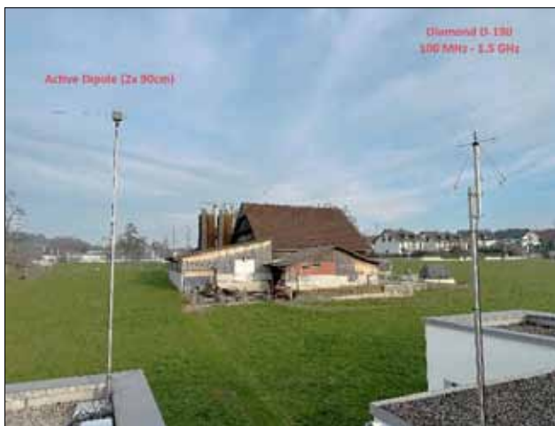
Bild 1: Empfangsantennen auf dem Dach
